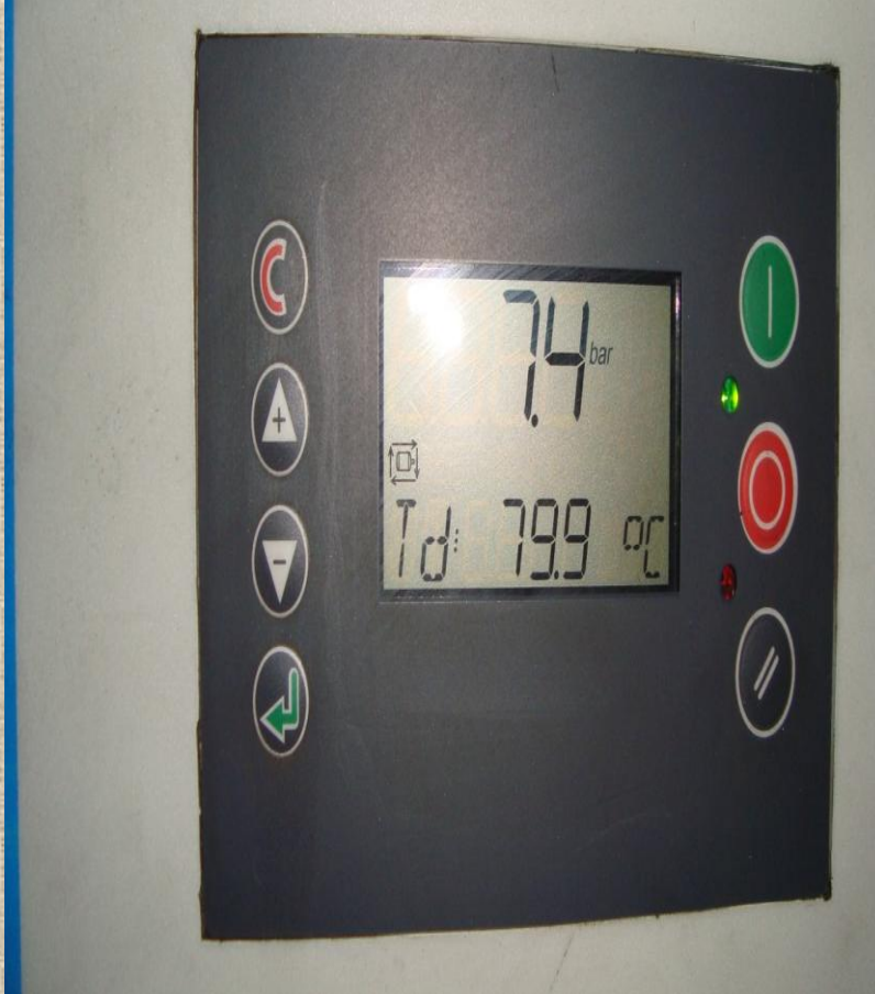
Fotoğraf 3-4 : Ay Döküm AŞ. Kompresör Odası-Kompresör Yağ Sıcaklığı ve boyler suyu sıcaklığı
