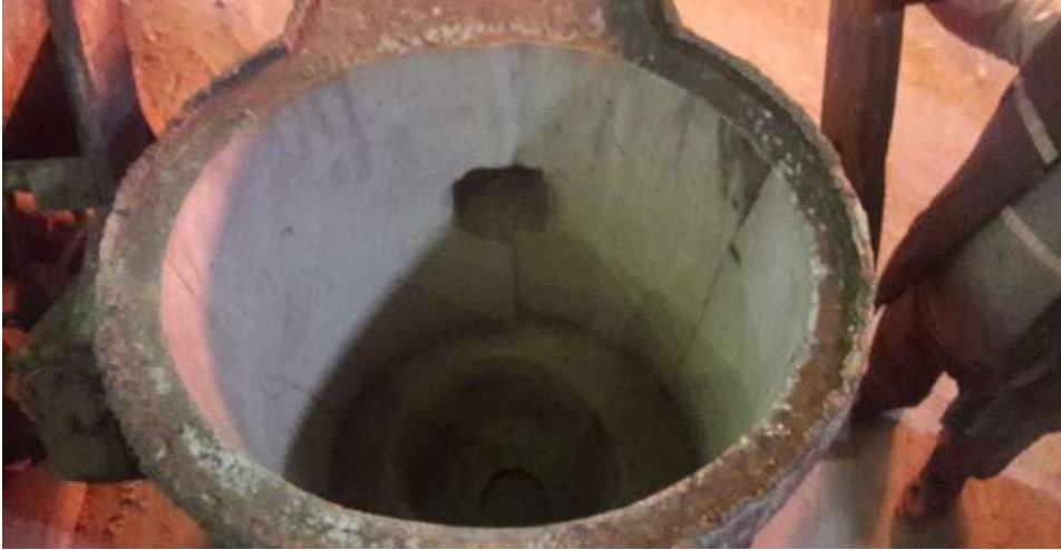
Şekil 4. Boş potaya ana beton şablonu yerleşimi ve beton atılması.
